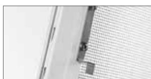
Rahmenbefestigung mittels Einhängewinkeln
