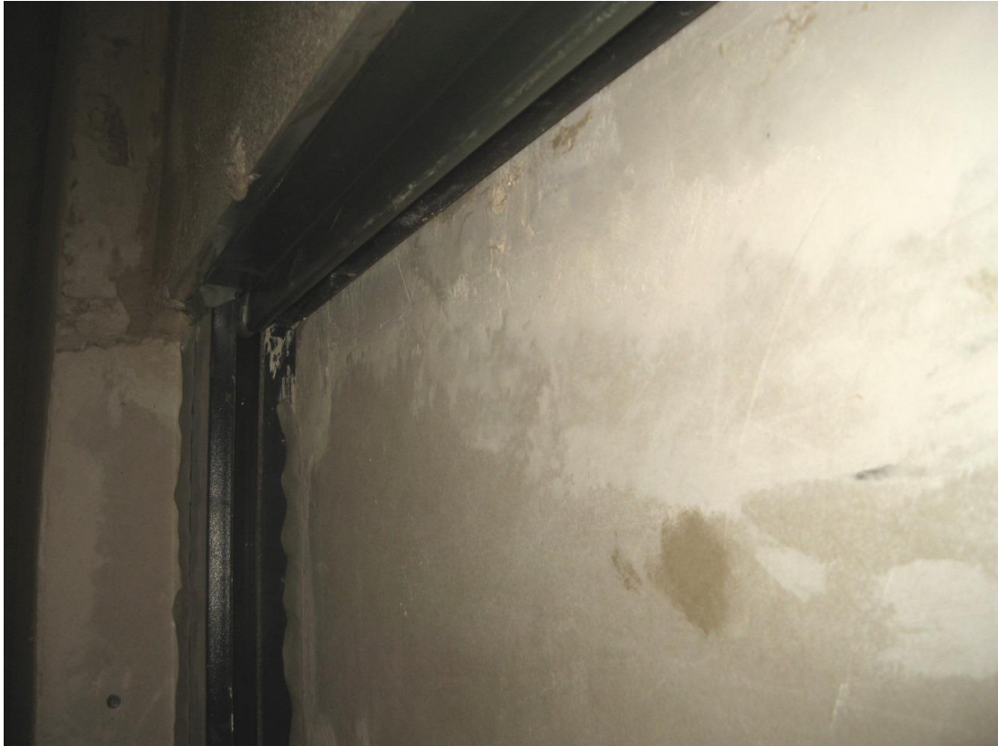
Bild 3: ROKA - TOP 2 EX 30/30, Senderraum, Detail (Messung 3)
