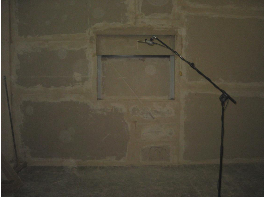
Bild 1: ROKA - TOP® 2 365/300 / ROKA - THERM® 2 365/300, mit Lüfter AERECO, Ansicht Senderraum
