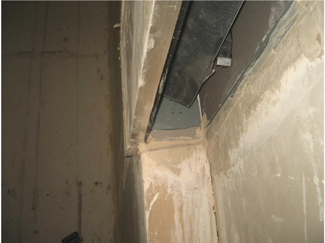
Bild 5: ROKA - TOP® 2 SHADOW / ROKA - SHADOW® 2 mit Lüfter AERECO, Detail Raffstore
