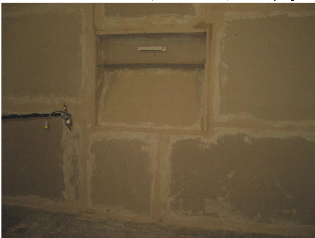
Bild 4: ROKA - TOP 2 Shadow / ROKA - SHADOW ® 2, mit Lüfter AERECO, Ansicht Empfangsraum
