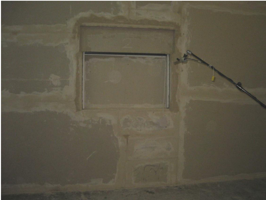
Bild 7: Ansicht Senderraum, Messung 7
