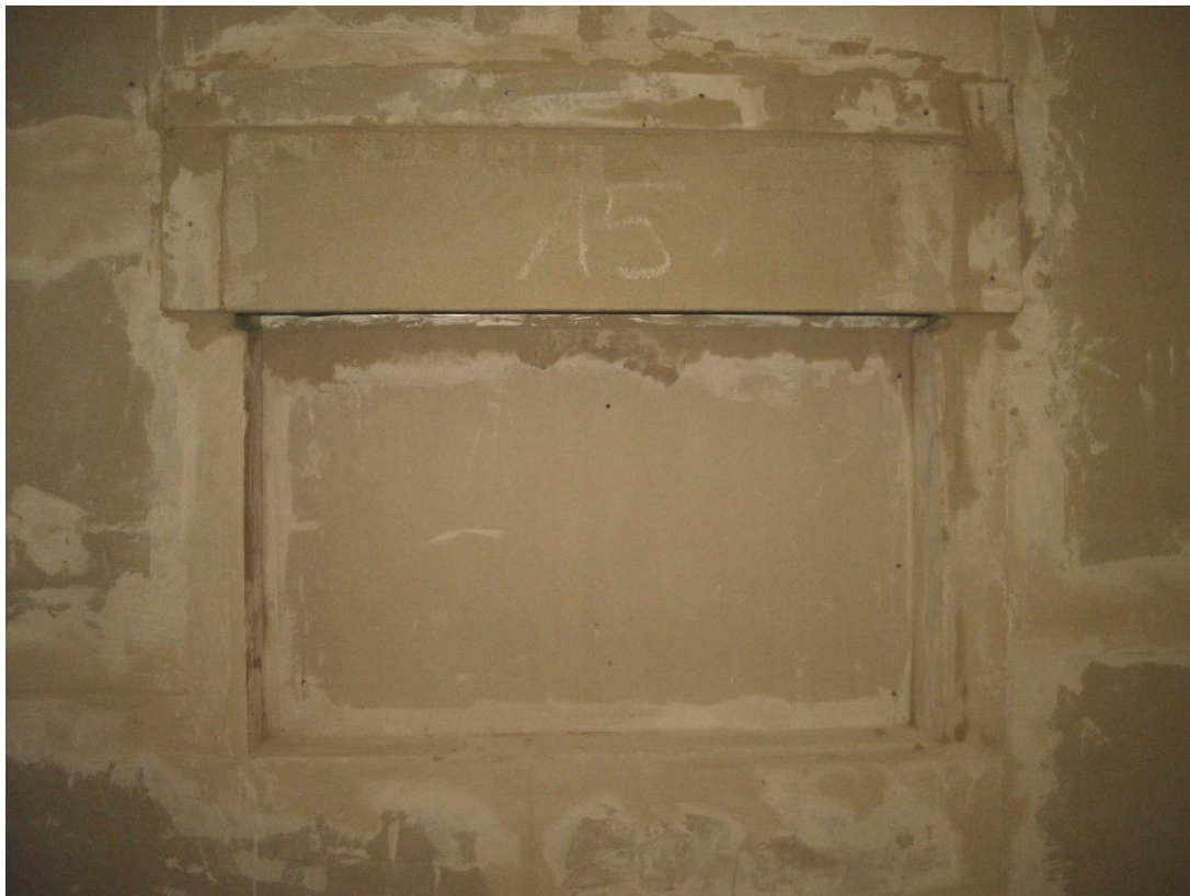
Bild 3: ROKA - TOP ® 2 Shadow / ROKA - SHADOW ® 2, mit Lüfter AERECO, Ansicht Senderraum
