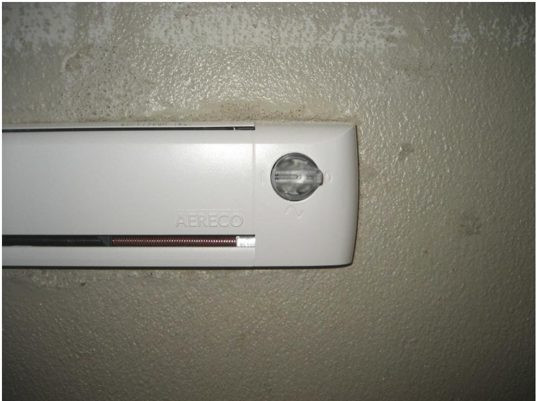
Bild 6: ROKA - TOP® 2 SHADOW / ROKA - SHADOW® 2 mit Lüfter AERECO, Detail Lüfter geöffnet
