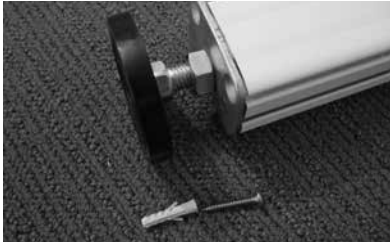
Abb. 18: Spannteller mit Kontermutter und Sicherungsschraube
