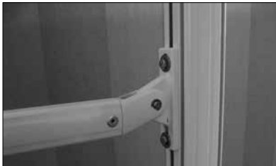
Abb. 20: Ausfallarme am Spannelement
